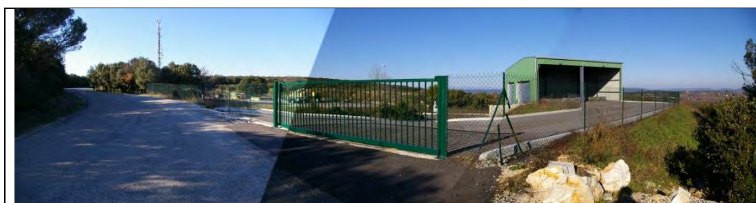
Déchetterie de St-Marcel-de-Careiret (à la Plaine de Gimel) et pylône relai SFR
