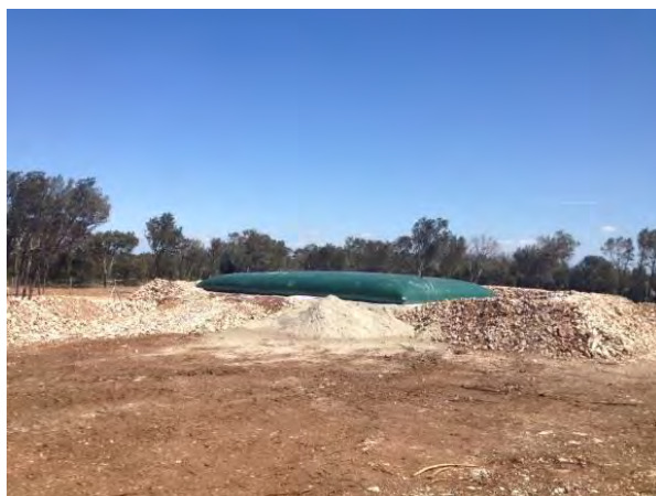
Réserve de 120 m 3 d'eau pour la lutte contre l'incendie sur l'emprise du projet
