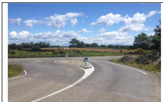
Sortie aménagée de la route d'accès à la déchetterie et à la carrière sur la RD9
